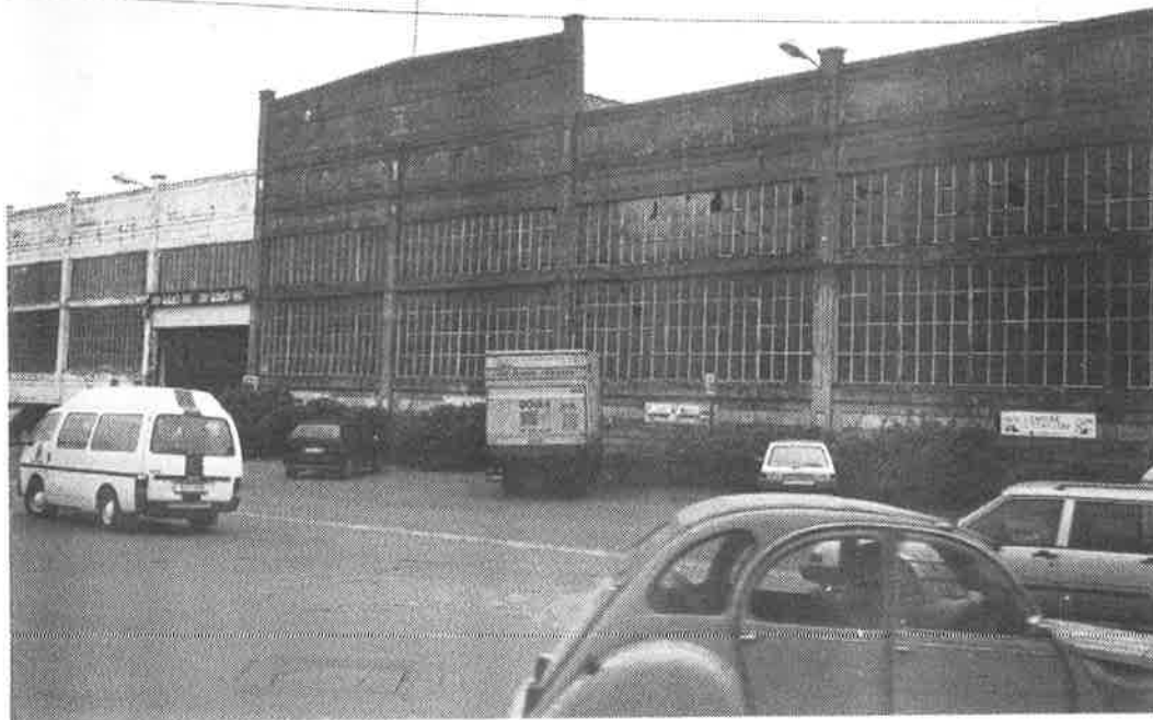
Façade de l'usine Henricot n° 2
